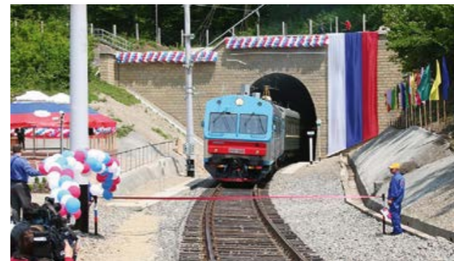
Тоннели участка Армавир–Туапсе Северо-Кавказской железной дороги
