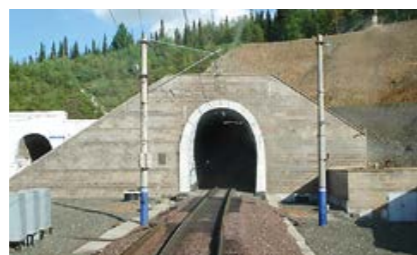
Джебский тоннель, Красноярский край
