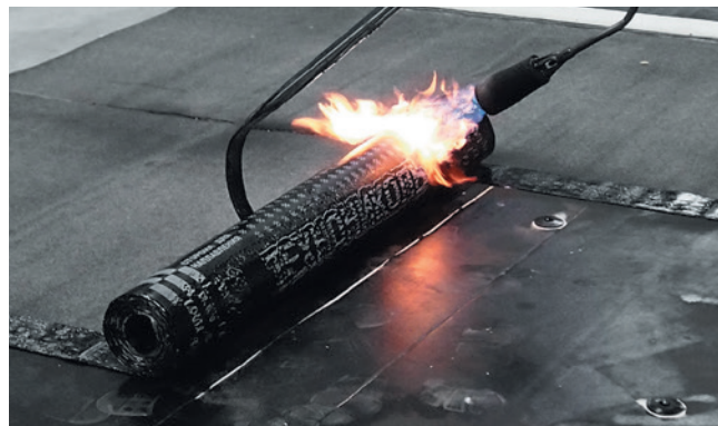
Рис. К.1. Наплавление по теплоизоляционным плитам
