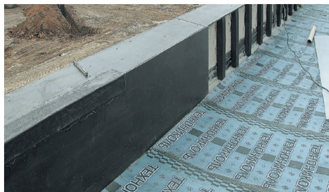
Рис. 7.15. Обшивка хризотилцементными плоскими листами (цементно-стружечными плитами марки ЦСП-1) вертикальной поверхности
