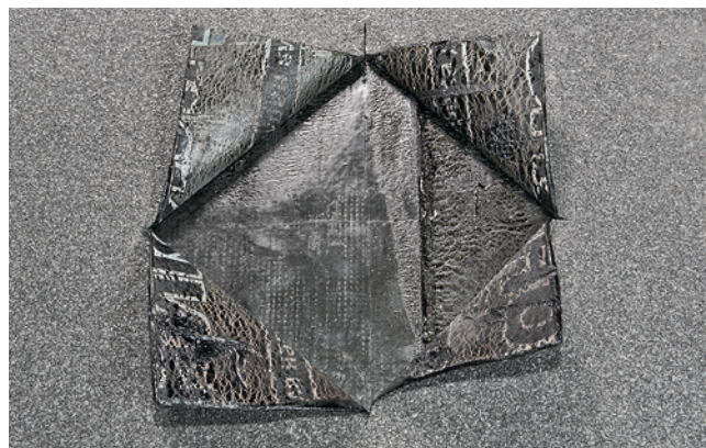
Рис. 8.2 Устранение вздутия водоизоляционного ковра
