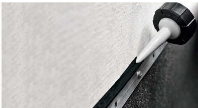
Рис. 7.24. Герметизация края краевой рейки
