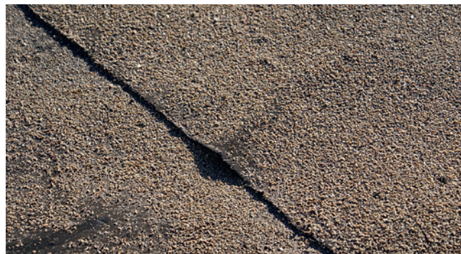
Рис. 4.5. Расслоение полотнищ материала
