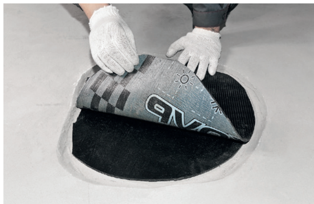
Рис. 9.1 Установка заплат
