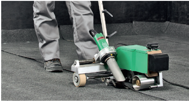
Рис. 7.47. Сварка шва автоматическим оборудованием
