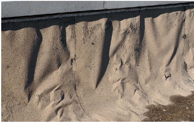
Рис. 4.12. Отслоение верхней кромки кровельного материала
