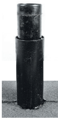
Рис. 7.33. Примыкание кровли к трубе
