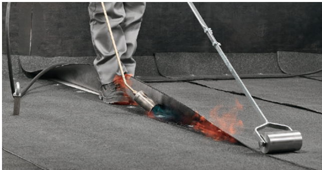
Рис. 7.48. Сварка шва с использованием газовой горелки
