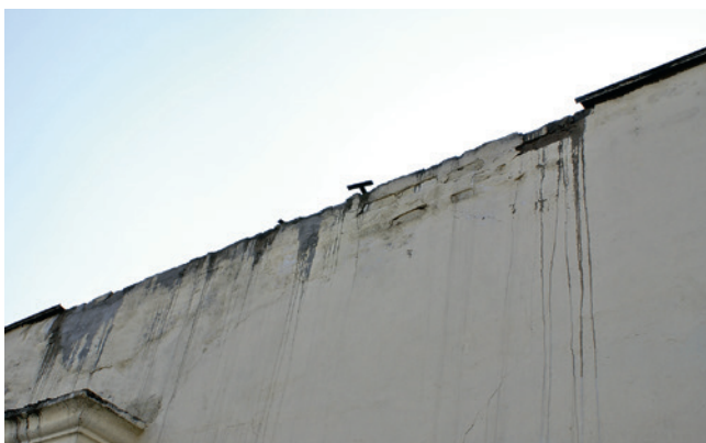
Рис. 4.17. Отсутствие картин карнизного свеса
