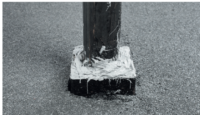
Рис. 7.37. Примыкание кровли к трубам малого диаметра
