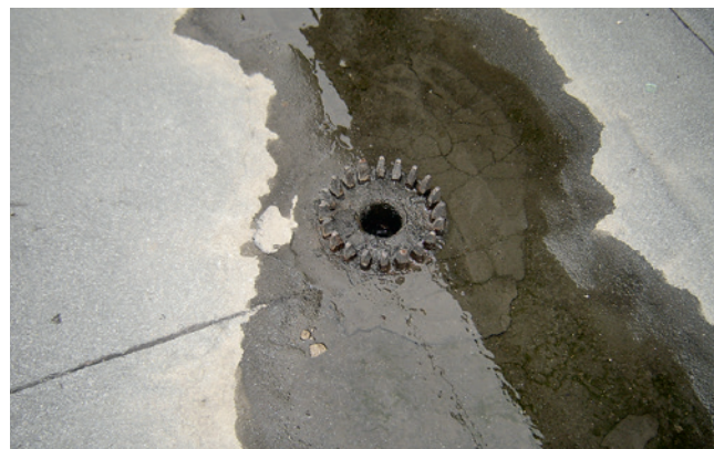
Рис. 4.15. Образование застойных зон
