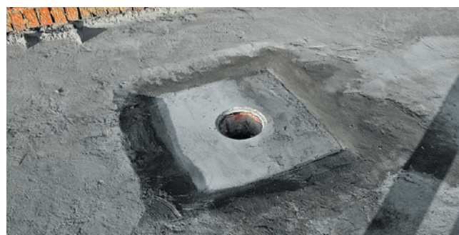
Рис. 7.12. Локальное понижение в месте установки воронки
