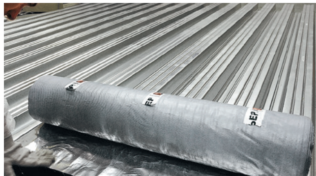
Рис. 7.5. Укладка пароизоляционного материала по профлисту
