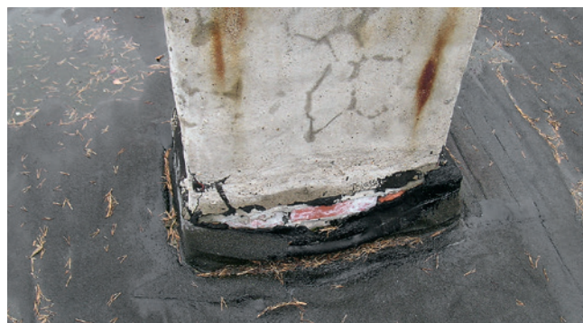
Рис. 4.10. Сползание кровельного материала с вертикальной поверхности
