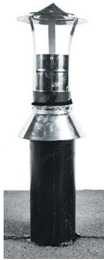
Рис. 7.34. Устройство защитного фартука на трубе
