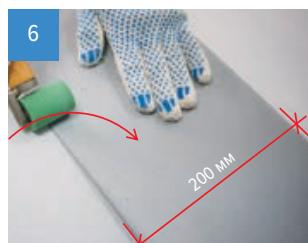
Далее необходимо приварить LOGICROOF NG к мемbrane при помощи автоматического оборудования через каждые 200 мм. Для этого сложите LOGICROOF NG в полосу шириной 200 мм, при этом прокатайте места сгиба силиконовым роликом.
