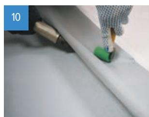
Если на монтируемом участке имеются застойные зоны, удалите с них воду, протрите мембранны очистителем для ПВХ мембранны и приварите LOGICROOF NG по всей площади застойной зоны при помощи ручного фена и силиконового ролика.
