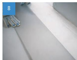
Далее разверните LOGICROOF NG и приварите следующий край аналогичным образом. Повторяйте процедуру до тех пор, пока не приварите всё полотно материала с шагом 200 мм.
