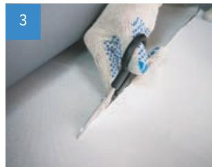
Обрезку материала осуществляйте только при помощи ножниц. Перед началом сварочных работ удостоверьтесь, что LOGICROOF NG лежит стороной с пропиткой вниз.
