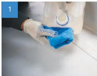
Перед началом работ по укладке защитного материала LOGICROOF NG удалите с поверхности ПВХ мембранны различный мусор, воду, лёд или снег. При необходимости удаления сильных загрязнений с поверхности мембранны в области сварного шва используйте Очиститель для ПВХ мембран ТЕХНОНИКОЛЬ.
