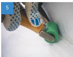
Приварите LOGICROOF NG к мемbrane вдоль стенки люка дымоудаления при помощи ручного фена с соплом 40 мм и силиконового ролика. Следите за тем, чтобы не пережечь материал. Сильное изменение цвета и большое количество дыма говорит о пережоге материала.
