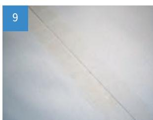
Для получения противопожарной рассечки шириной 2 м необходимо уложить по 2 полосы LOGICROOF NG вдоль каждой стороны люка дымоудаления. Раскатайте следующий рулон LOGICROOF NG. При помощи автоматического оборудования приварите мембранны встык к первому рулону. Осуществите приваривание второго рулона LOGICROOF NG к мемbrane аналогичным образом.
