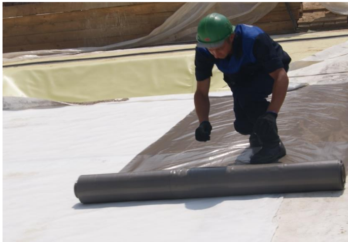
Рисунок 13.12 – Укладка полиэтиленовой пленки
