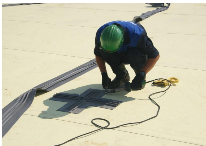
Рисунок 13.3 – Приварка гидрошпонки к ПВХ мембране, для секционирования гидроизоляционного полотна.
