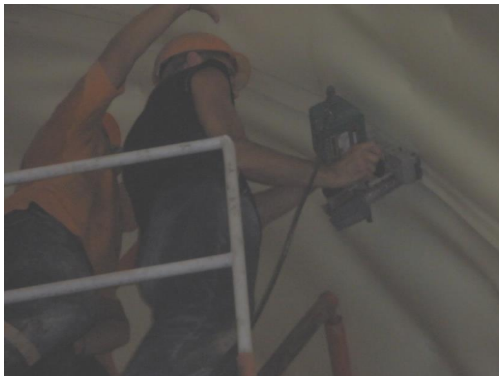
Рисунок 13.18 – Сварка полотен мембраны «LOGICBASE V-SL» в сводчатой части тоннеля.
