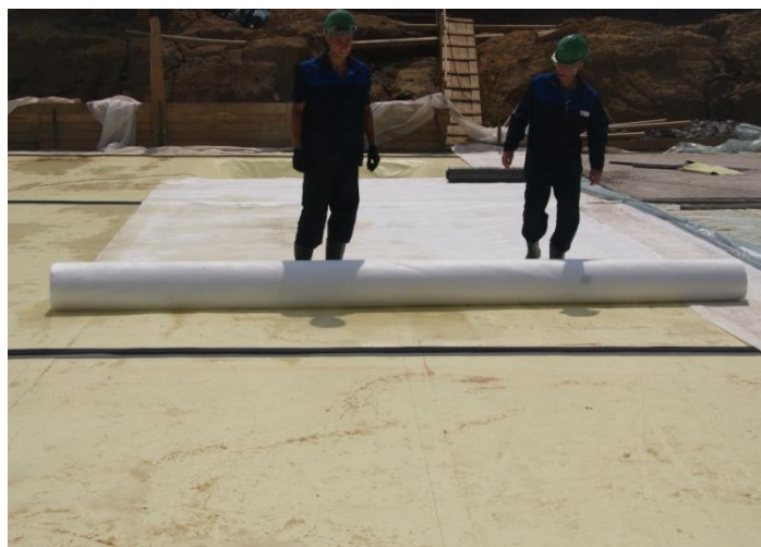
Рисунок 13.11 – Укладка защитного слоя геотекстиля.
