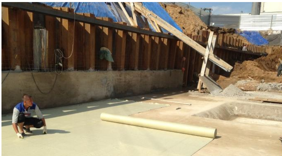
Рисунок 13.1 – Укладка геотекстиля как основания для гидроизоляции.
