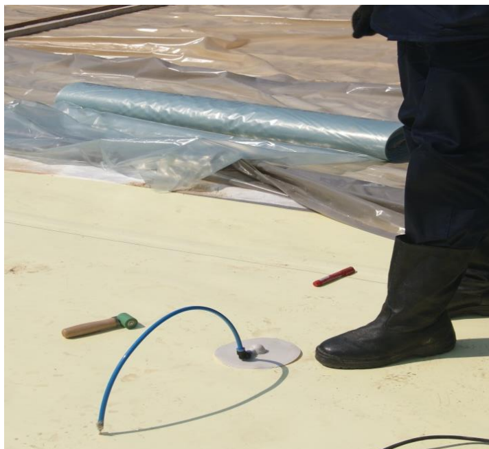
Рисунок 13.9 – Пример присоединения инъекционной трубки к штуцеру.
