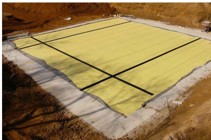
Рисунок 13.4 – Пример секционирования гидроизоляции путем приварки гидрошпонок.
