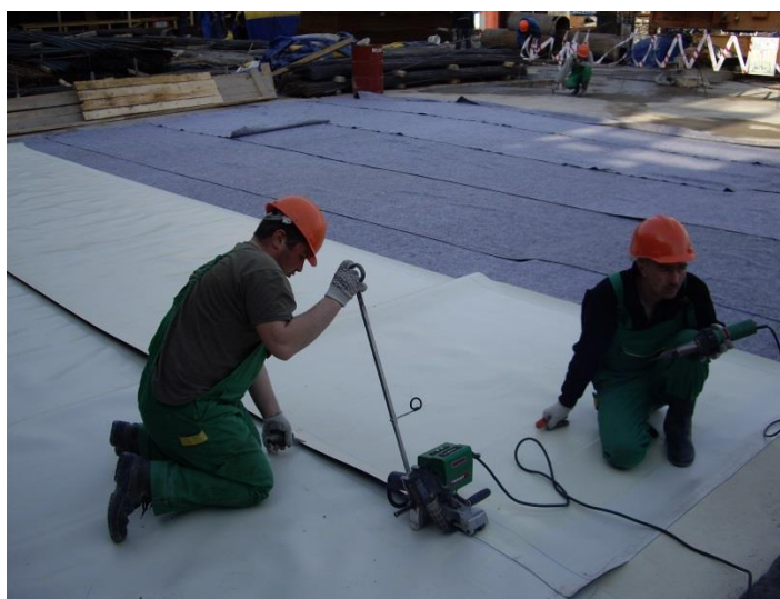
Рисунок 13.2 – Сварка ПВХ мембраны «LOGICBASE V-SL» автоматическим аппаратом «Leister Twinni-T».
