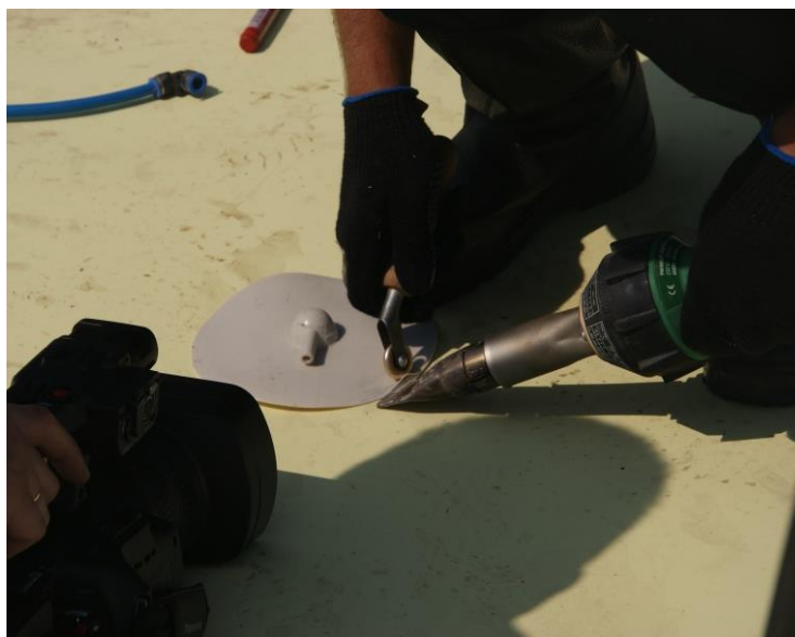
Рисунок 13.8 – Установка контрольно-инъекционных штуцеров.
