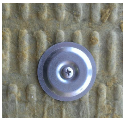
Рис. 3. Внешний вид крепления огнезащитного покрытия
