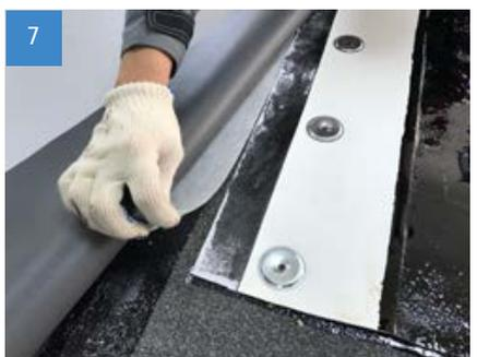
Для исключения прямого контакта ПВХ мембраны с битумными материалами уложите между ними разделительный слой из термообработанного геотекстиля развесом не менее 300 г/м<sup>2</sup>.
