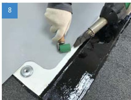
Заведите основной гидроизоляционный ковер на переходную ленту, перекрывая механический крепеж, и произведите сварку. Минимальная ширина сварного шва - 30 мм.
