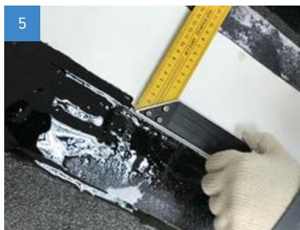
Со стороны БРМ нанесите мастику по всей широкой геотекстильной части ленты с нахлестом в 15-20 мм на битумостойкую полосу (приклейка "в замок").
