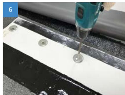
С помощью тарельчатого или телескопического крепежа и саморезов механически закрепите ленту к основанию с шагом 200-250 мм.
