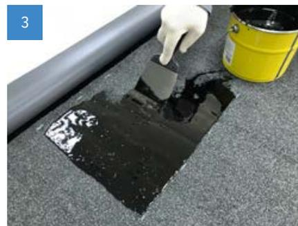
С помощью шпателя или щетки с жестким ворсом равномерно нанесите мастику\* - расход 1 кг/м<sup>2</sup> (толщина слоя = 1-2 мм).
