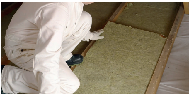
Рис.3.12. Монтаж теплоизоляции между балками
