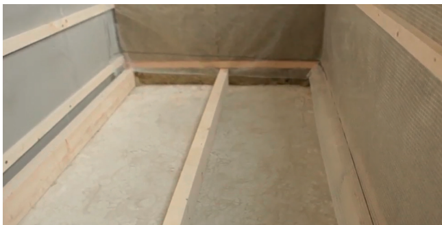
Рис. 5.8. Монтаж деревянных лаг на пол
