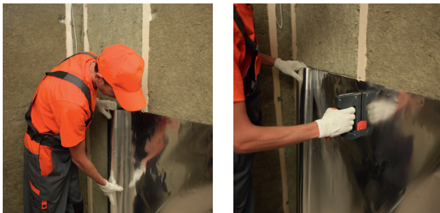
Рис. 4.3. Монтаж пароизоляции
