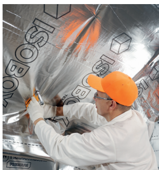
Рис. 3.6. Укладка и фиксация пароизоляционной пленки
