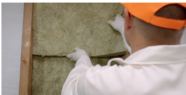
Рис. 2.3. Установка второго слоя теплоизоляции с разбежкой швов
