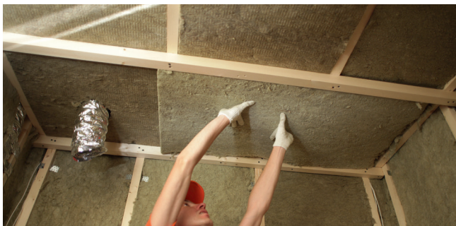
Рис. 4.2. Укладка плит теплоизоляции
