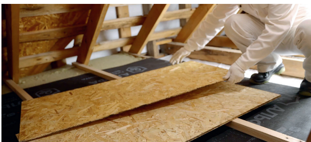
Рис. 3.14. Черновая обрешетка пола холодного чердака
