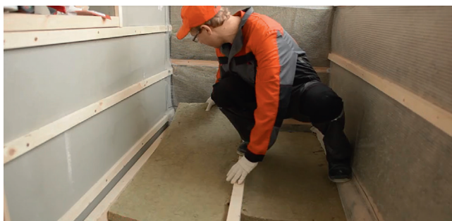
Рис. 5.9. Укладка теплоизоляционных плит
