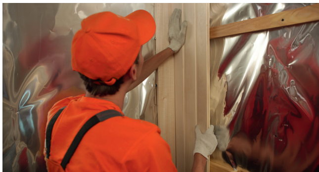
Рис. 4.5. Устройство внутренней обшивки
