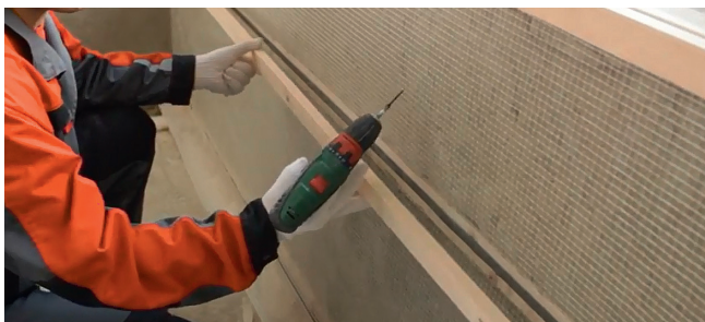
Рис. 5.6. Монтаж контррейки
