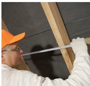
Рис. 3.2. Подготовленная система для дальнейшего монтажа теплоизоляции
