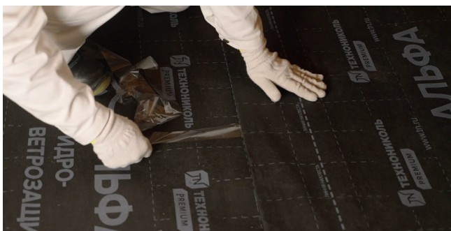
Рис. 3.13. Монтаж гидро-ветрозащитной мембраны
