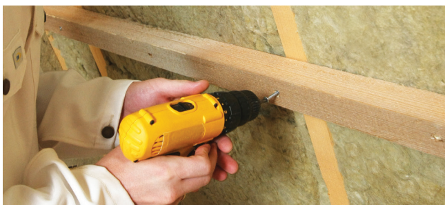
Рис. 3.4. Установка дополнительной деревянной обрешетки
