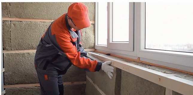
Рис. 5.4. Укладка плит теплоизоляции второго слоя
