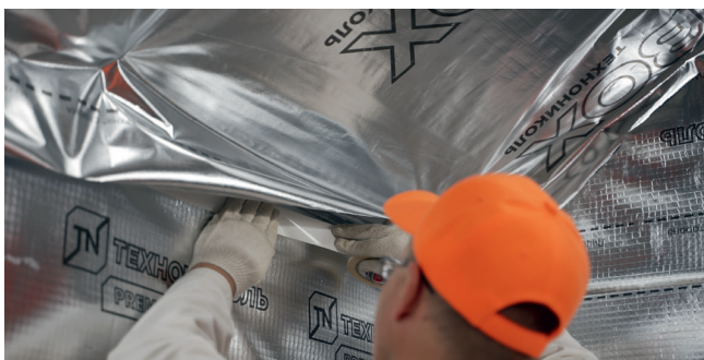
Рис. 3.7. Проклейка стыков пароизоляционной пленки
