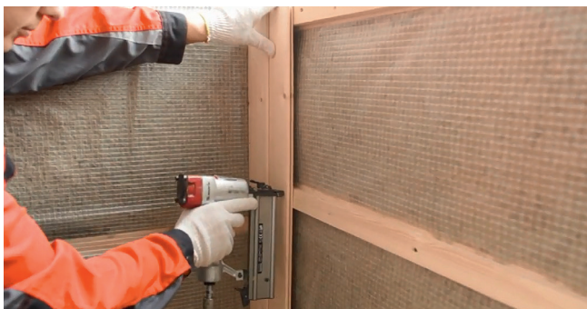
Рис. 5.7. Устройство внутренней обшивки
