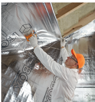
Рис. 3.6. Укладка и фиксация пароизоляционной пленки
