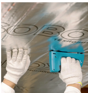
Рис. 3.10. Монтаж пароизоляционной пленки
