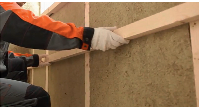
Рис. 5.3. Установка горизонтального каркаса под теплоизоляцию
