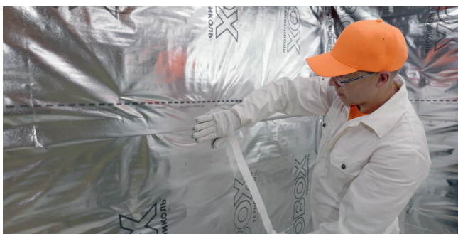
Рис. 2.7. Герметизация стыка двух полотен пленки
