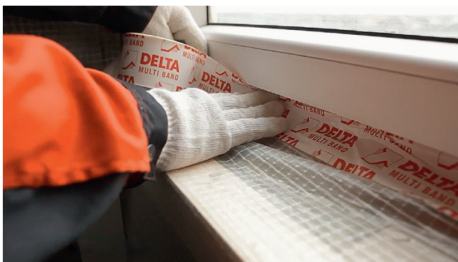
Рис. 3.12. Проклейка примыканий пароизоляции к стенам и окну
