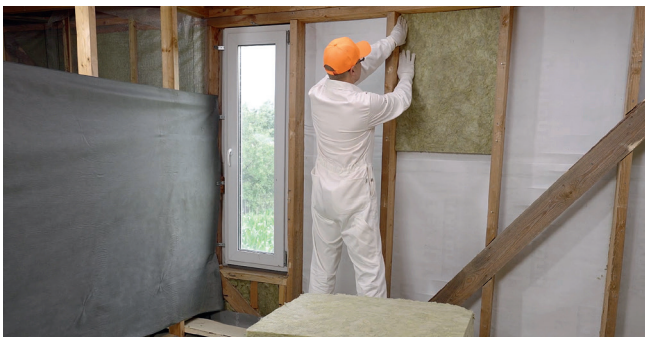
Рис. 2.2. Установка теплоизоляции враспор между стойками каркаса
