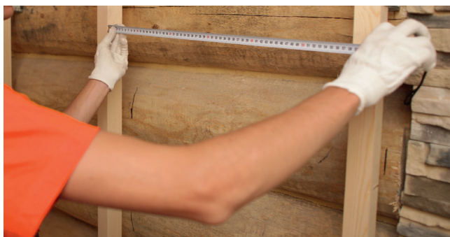
Рис. 4.1.а. Установка каркаса под теплоизоляцию
