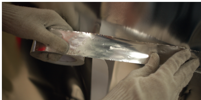
Рис. 4.4. Проклейка стыков пароизоляции
