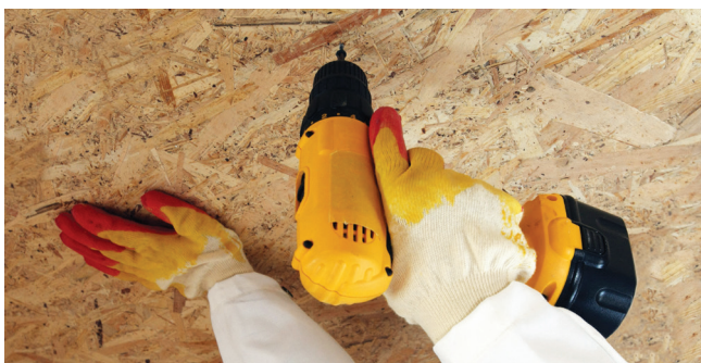
Рис. 3.11. Подшивка потолка листами ОСП
