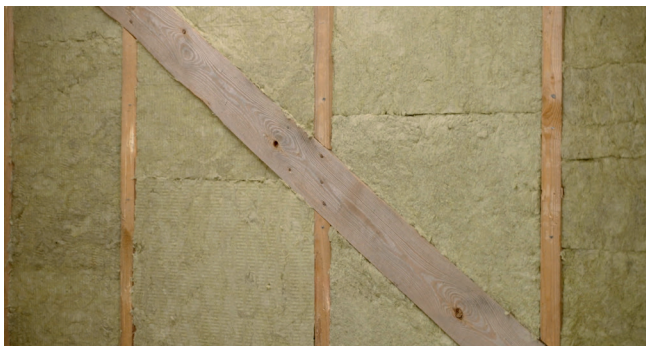
Рис. 2.4. Смонтированная теплоизоляция
