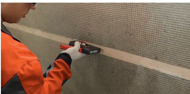
Рис.5.5. Монтаж пароизоляции
