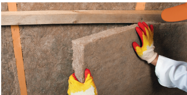
Рис. 3.5. Укладка дополнительного слоя теплоизоляции
