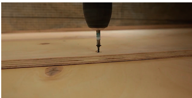
Рис. 3.13. Установка покрытия пола
