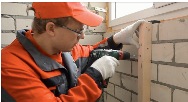
Рис. 5.1. Установка вертикального каркаса под теплоизоляцию
