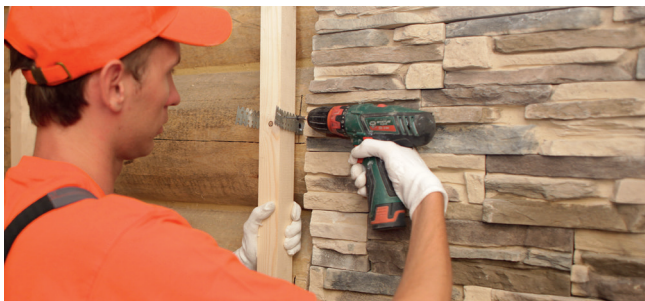
Рис. 4.1б. Установка каркаса под теплоизоляцию
