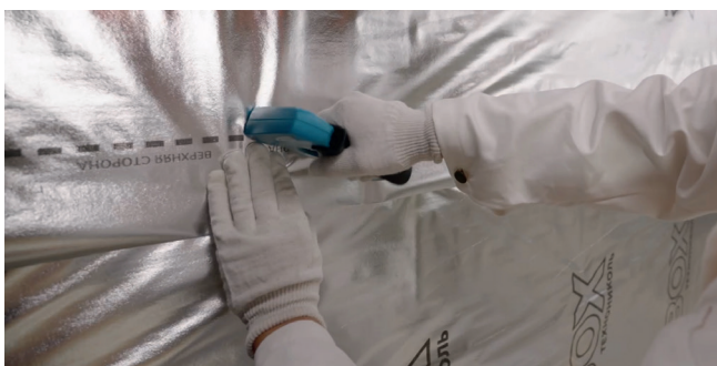
Рис. 2.5. Укладка и фиксация пароизоляционной пленки
