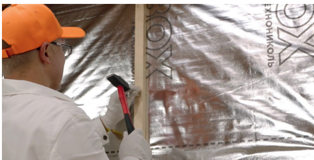
Рис. 2.8. Монтаж контрреек для устройства внутренней облицовки
