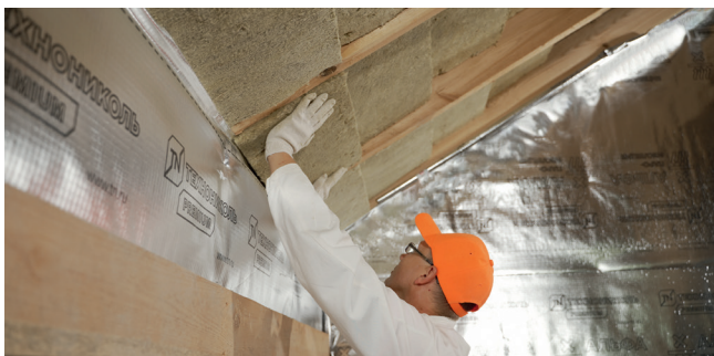
Рис. 3.3. Монтаж теплоизоляции враспор между стропилами
