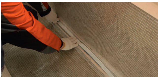
Рис. 3.11. Проклейка нахлестов пароизоляции
