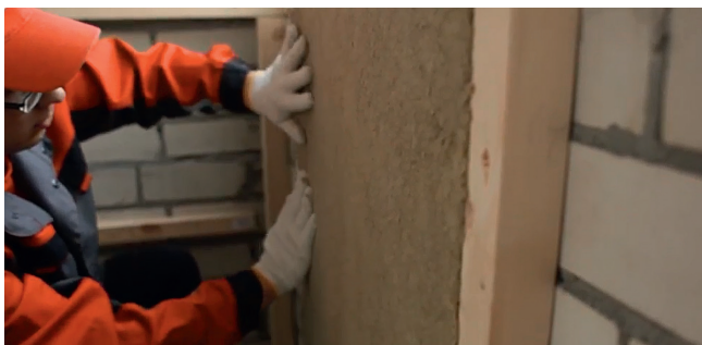
Рис. 5.2. Укладка плит теплоизоляции первого слоя
