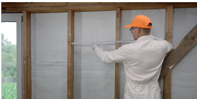
Рис. 2.1. Контрольный замер шага стоек каркаса
