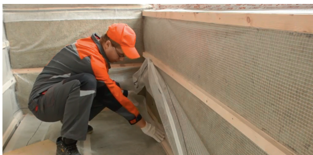
Рис. 5.10. Монтаж пароизоляционной пленки
