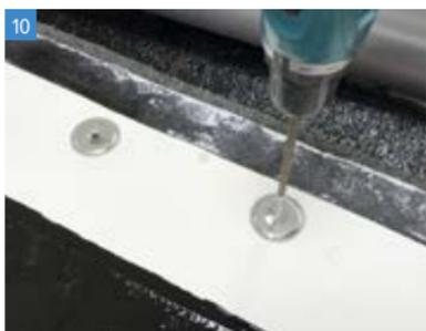
С помощью тарельчатого крепежа или телескопического элемента с саморезом механически закрепите ленту к основанию с шагом 200-250 мм.
