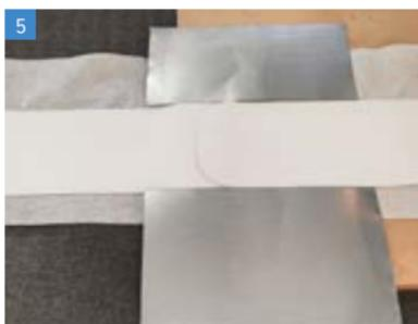
Геотекстиль в районе стыковки двух полотен нужно закрыть негорючим материалом (оцинкованной листовой сталью), чтобы не прожечь.
