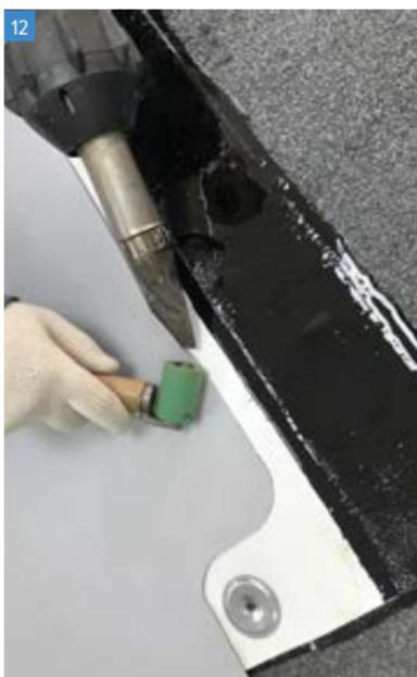
Далее необходимо завести основной гидроизоляционный ковер на участок ленты с ПВХ мембраной, перекрывая механический крепеж, и произвести сварку между собой с помощью аппаратов горячего воздуха. Минимальная ширина сварного шва — 30 мм.
