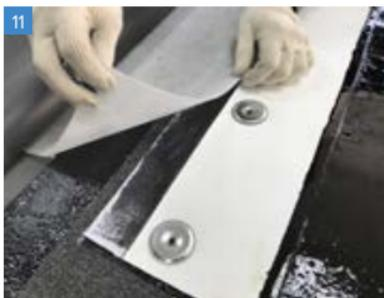
Для исключения прямого контакта водоизоляционного ковра из ПВХ мембраны с битумными материалами уложите между ними разделительный слой из термообработанного геотекстиля развесом не менее 300 г/м<sup>2</sup>.
