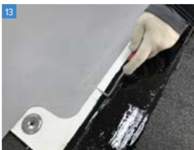
После приварки основного гидроизоляционного ковра к переходной ленте необходимо проверить качество шва с помощью пробника. Для повышения герметичности сварного шва рекомендуется нанести на него жидкий ПВХ ТЕХНИКОЛЬ.
