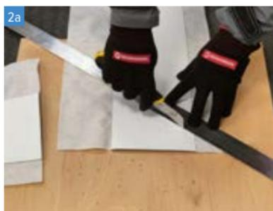
При угловом стыковании лент их края должны иметь ровный срез в 45 градусов либо другой соответствующий соединению угол.
