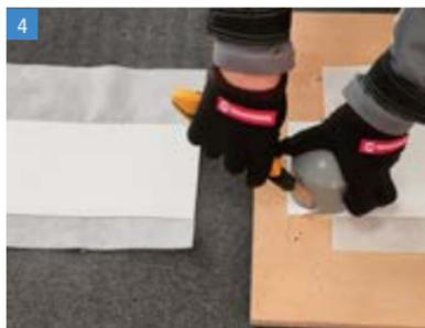
Далее край ленты, освобожденный от геотекстиля, следует подготовить к сварке горячим воздухом. Для этого нужно закруглить его уголки.
