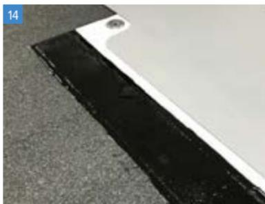
После полного высыхания мастики, лента обеспечивает полную герметичность соединения гидроизоляционных материалов.
