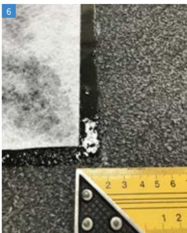
С помощью металлического шпателя (а) или щетки с жестким ворсом (б) равномерно нанести мастику\* с расходом 1 кг/м<sup>2</sup> (толщиной слоя ≈ 1 мм) на очищенном и ранее размеченном участке.
