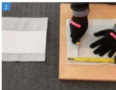
С края одной из лент необходимо удалить геотекстиль на ширину в 5 см. Если геотекстиль не приклеен, его можно отрезать ножницами или ножом.
