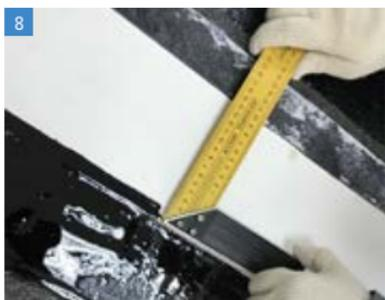
Со стороны битумного гидроизоляционного ковра нанести мастику на всю ширину геотекстильной части ленты (расход в соответствии с п. 4) с нахлестом в 15-20 мм на битумостойкую ПВХ мембрану.
