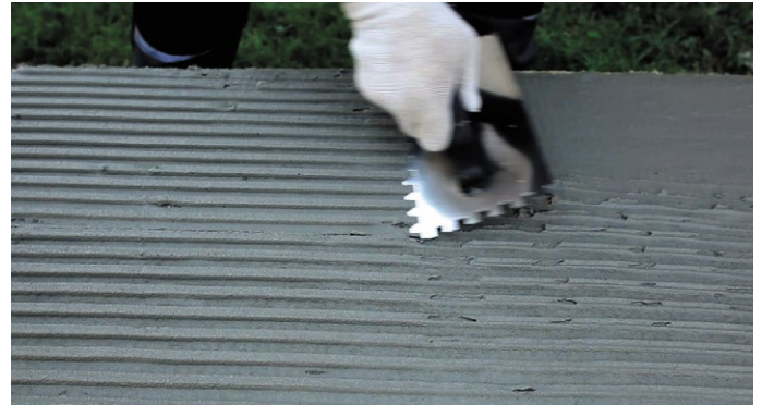
Рис. 4. Нанесение клеевого состава на плиту сплошным методом приклейки
