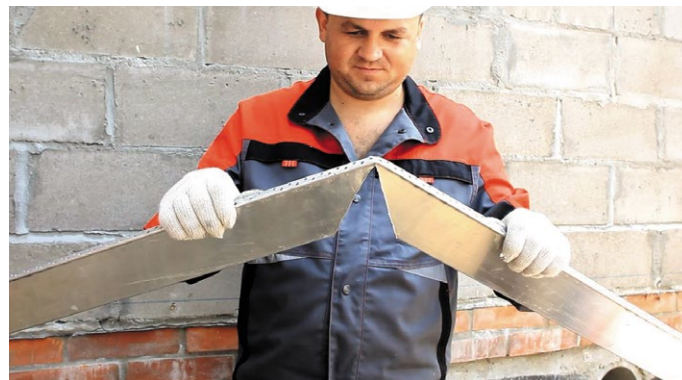
Рис. 2. Установка опорного профиля для первого ряда теплоизоляции а) с применением алюминиевого стартового профиля
