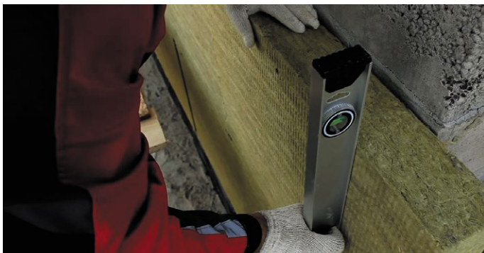
Рис. 8. Приклейка плиты тепло-, звукоизоляции к стене
