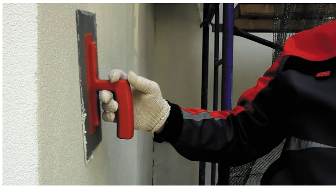
Рис. 18. Нанесение декоративного слоя штукатурки
