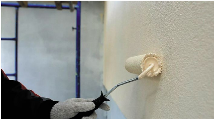
Рис. 19. Нанесение краски на поверхность фасада
