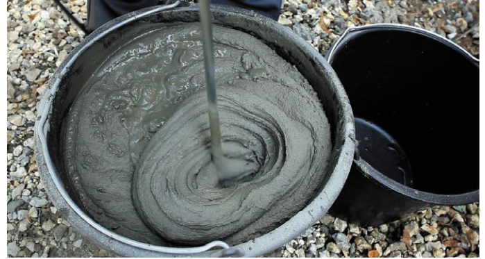
Рис. 3. Замешивание клея для приклейки теплоизоляции
