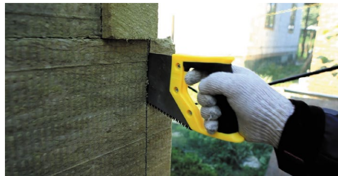
Рис. 10. Зубчатая перевязка плит на наружных углах здания
