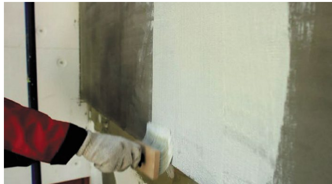
Рис. 17. Нанесение кварцевой грунтовки на поверхность базового штукатурного слоя
