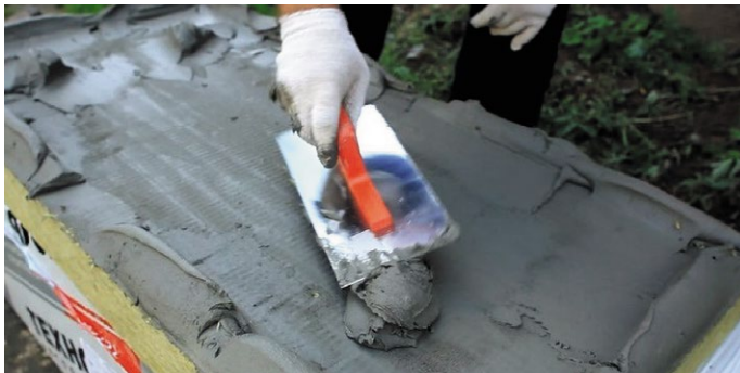
Рис. 6. Нанесение клея на плиту контурно-маячковым методом приклейки
