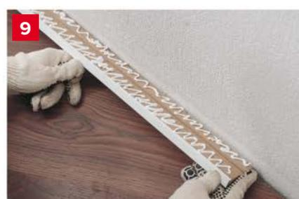
**9** Прикрепите изделие к размеченному месту крепления. Допускается немного сдвинуть изделие, не отрывая его от поверхности.
