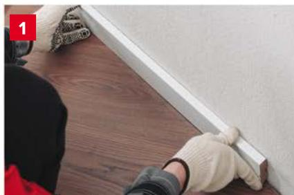
**1** Перед началом работ приложите приклеиваемое изделие к месту крепления без нанесения клея. Разметьте место крепления при помощи карандаша.
