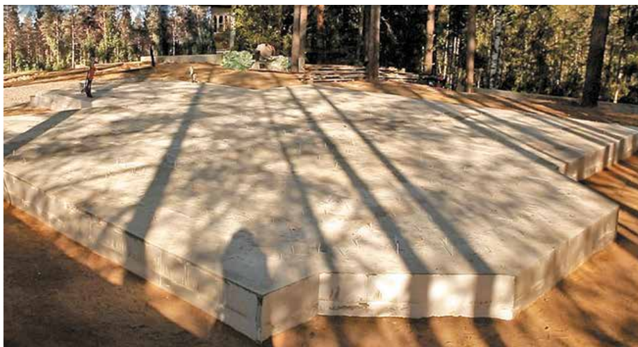
Готовая поверхность плиты
