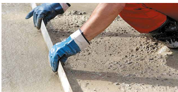
Разравнивание бетонной смеси, контроль ровности поверхности проводить с помощью ротационного нивелира.
