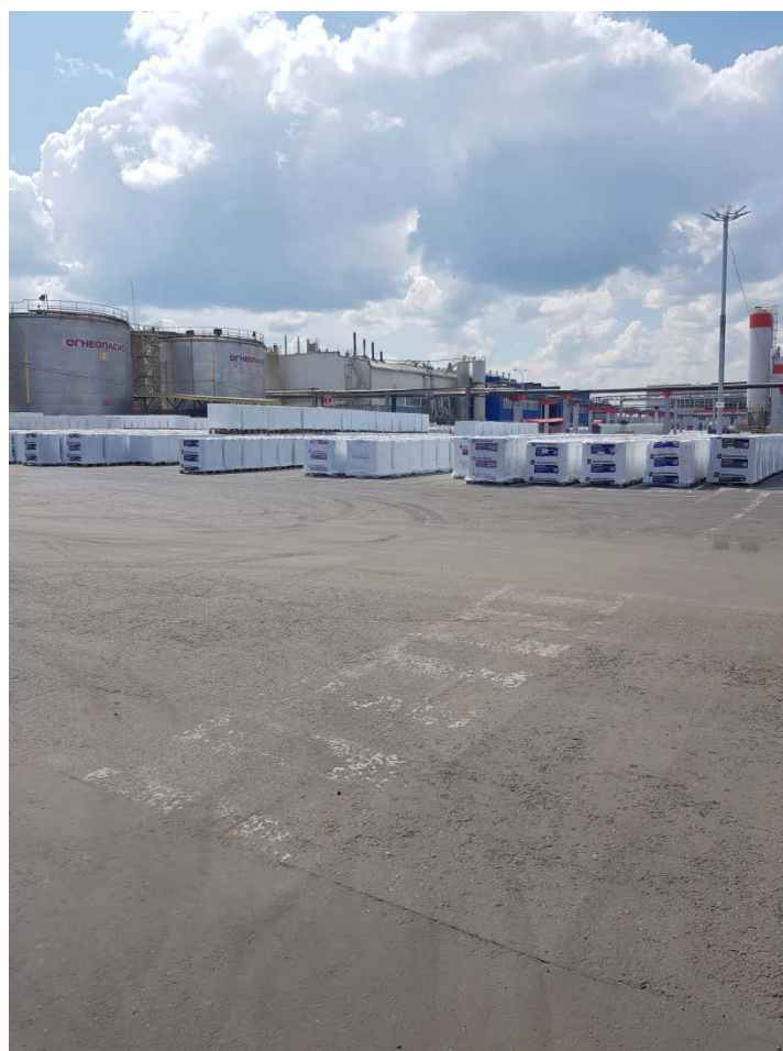
Фото 2. Битуохранилища с трубопроводом
