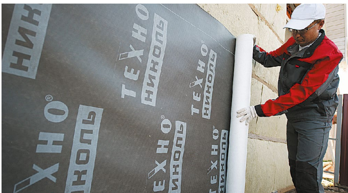
Рис. 5 а. Монтаж ветро-, влагозащитной мембраны
