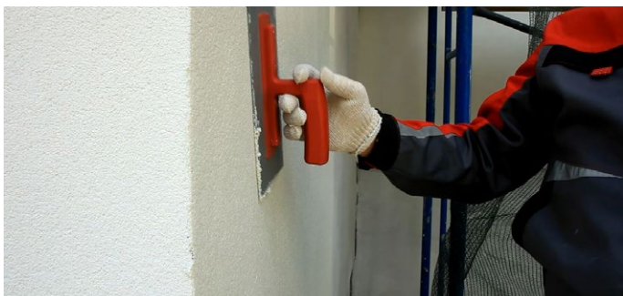
Рис. 39. Нанесение декоративного слоя штукатурки
