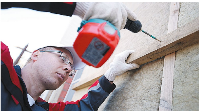
Рис. 3. Установка горизонтального каркаса
