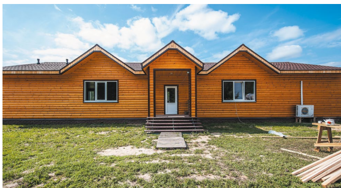
Рис. 22. Монтаж облицовочного материала
