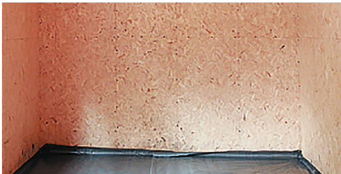
Рис. 23. Обшивка внутренней поверхности стен
