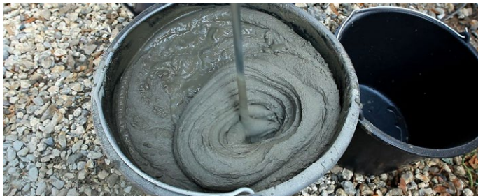
Рис. 25. Замешивание клея для приклейки теплоизоляции
