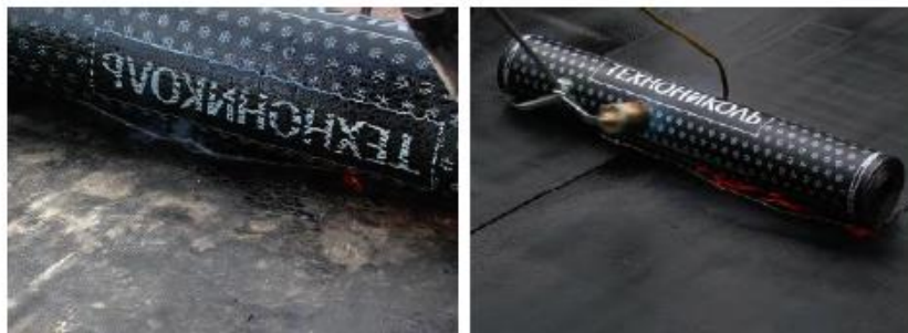
Рис. 7. Валик расплавленного битумно-полимерного вяжущего
