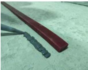
**ВНИМАНИЕ!** Расстояние до края стены от герметика и установленного шнура с каждой стороны должно составлять не менее 8 см. Укладку бетона производить не ранее чем через 2-3 часа после нанесения герметика. Набухающий герметик ТЕХНОНИКОЛЬ требуется оградить (первые 24 часа) от преждевременного контакта с водой.
