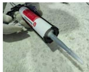
Подготовьте к работе пистолет для герметика. Для этого вложите тубу в пистолет и закрепите его корпус. Соблюдайте правила инструкции использования пистолета.
