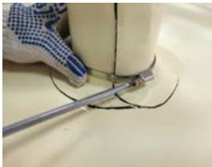
После окончания сварки мембраны установите хомут соответствующего диаметра, который должен надежно фиксировать мембрану на трубе.
