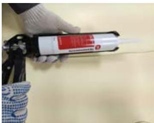
Заполните образовавшуюся пазуху герметиком по всему контуру трубы до образования видимого вздутия. После того как пазуха между мембраной и трубой заполнена герметиком, установите второй хомут на расстоянии не менее 30-50 мм от первого хомута.
