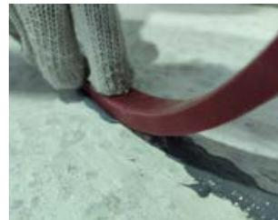
Для фиксации профилей LOGICBASE IC-SP 20x10 уложите полимерный профиль поверх нанесенного в середине шва герметика. Зафиксируйте его плавным прижатием в свеженанесенный герметик. Минимальное расстояние от края шва до профиля должно быть не менее 8 см со всех сторон. Для наилучшей фиксации при укладке профиля рекомендуется в местах остаточного напряжения предусмотреть дополнительный механический прижим.
