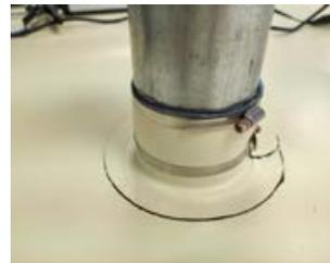
В качестве дополнительной герметизации рекомендуется обработать край мембраны ПУ герметиком ТЕХНОНИКОЛЬ LOGICFLEX. Для этого, при необходимости, удалите излишки набухающего герметика и нанесите ПУ герметик ТЕХНОНИКОЛЬ LOGICFLEX таким образом, чтобы он закрывал верхний хомут и соединялся с основанием трубы, образовав герметичный замок.
