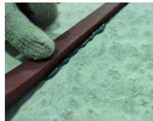
**ВНИМАНИЕ!** Укладку бетона производить не ранее чем через 2-3 часа после нанесения герметика. Во избежание преждевременного запуска процесса набухания профиля LOGICBASE IC-SP 20x10 следует защитить его от попадания влаги.
