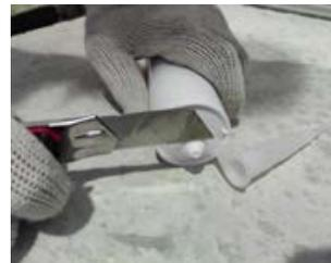
Срежьте пластиковый конус-наконечник на тубе. Установите носик и срежьте под углом для удобства нанесения герметика. Для увеличения наносимого слоя герметика сделайте больший срез носика:
