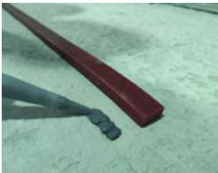
На подготовленную поверхность бетона нанесите герметик медленным, однообразным движением. Для этого выдавите достаточное количество герметика из тубы. Нанесение производить полосой без разрывов посередине шва бетонного элемента. Если бетонная поверхность имеет шероховатости, количество герметика должно быть достаточным, чтобы выровнять их.
