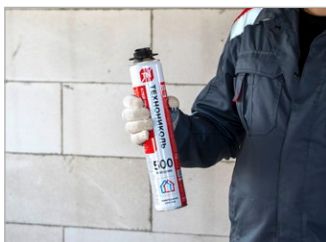
Рис. 6. Подготовка баллона и нанесение клея-пены
