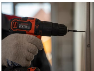
Рис. 16. Крепление листов ГКЛ/ГВЛ второго слоя
