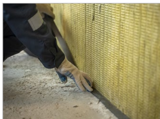
Рис. 11. Укладка виброизоляционной ленты
