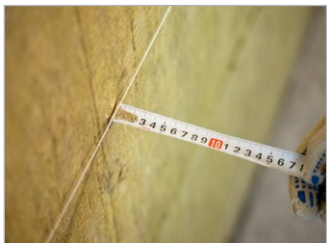
Рис. 10. Монтаж звукоизоляции
