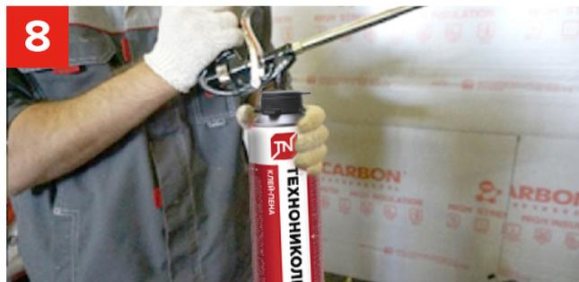
Для предотвращения образования мостиков холода более крупные зазоры между плитами необходимо плотно заполнить обрезками пенополистирола и КЛЕЙ-ПЕНОЙ ТЕХНОНИКОЛЬ для пенополистирола.
