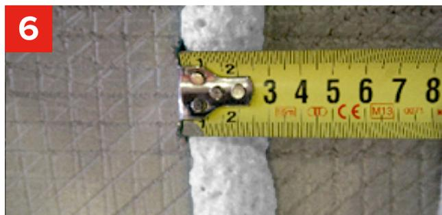
По периметру КЛЕЙ-ПЕНУ ТЕХНОНИКОЛЬ для пенополистирола следует наносить, с отступом примерно 2 см от края. Ширина полос около 3 см.
