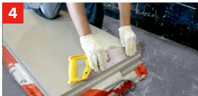
Перед началом монтажа плит XPS, поверхность необходимо отфрезеровать для увеличения адгезии. Фрезеровка может выполняться ножовкой по дереву или щеткой с металлическим ворсом. При использовании плит XPS ТЕХНОНИКОЛЬ CARBON ECO FAS фрезеровка не требуется.
