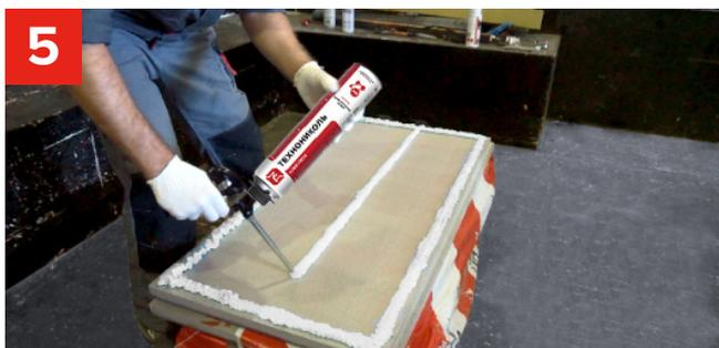
Нанести КЛЕЙ-ПЕНУ ТЕХНОНИКОЛЬ для пенополистирола по периметру плиты и одной полосой по центру.
