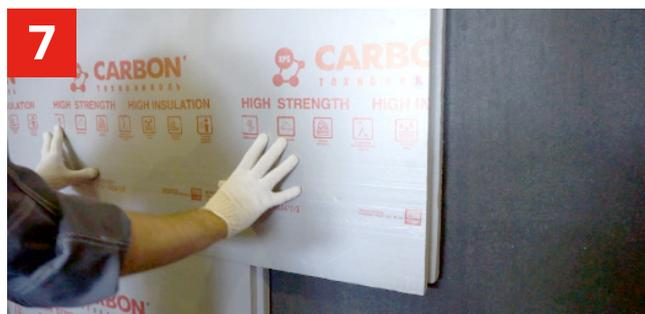
Приложить плиту с КЛЕЙ-ПЕНОЙ ТЕХНОНИКОЛЬ к стене и слегка надавить. Зафиксировать плиту до момента схватывания клея. Плиты следует крепить вплотную одна к другой. Зазор между плитами не должен превышать 2 мм.
