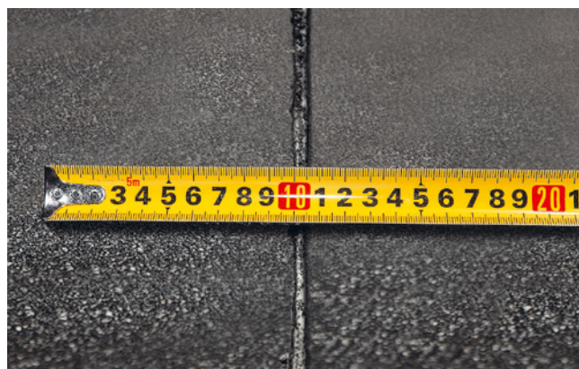
Рис. 4.10. Вытек битумного вяжущего из-под кромки материала
