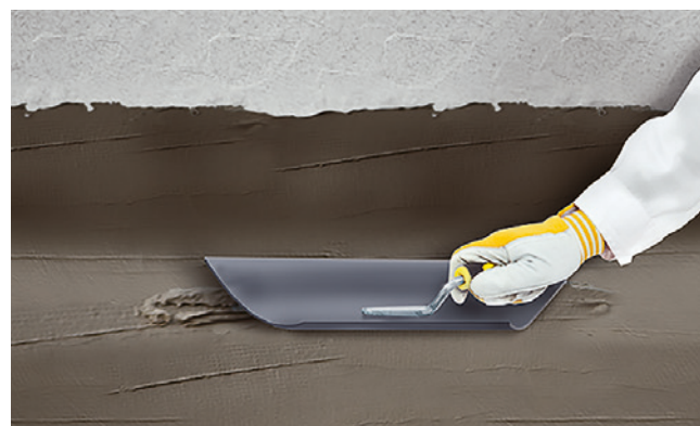
Рис. 3.3. Устройство выкружки
