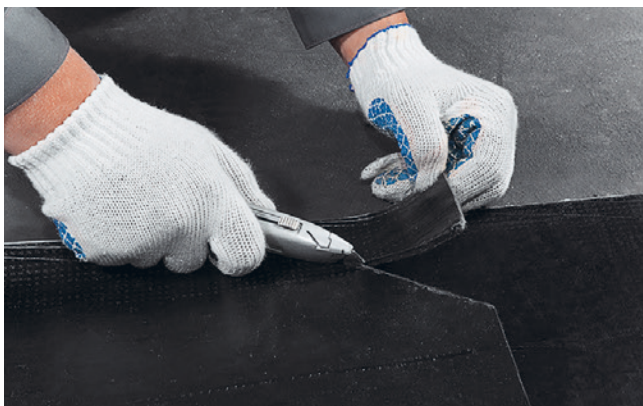
Рис. 4.5. Подрезка угла рулона в Т-образном шве
