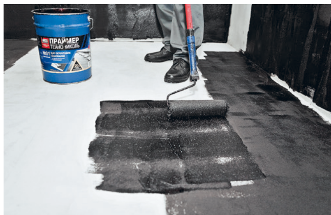
Рис. 3.5. Нанесение праймера
