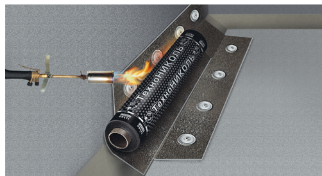
Рис. 5.7. Наплавление рулона на слой усиления
