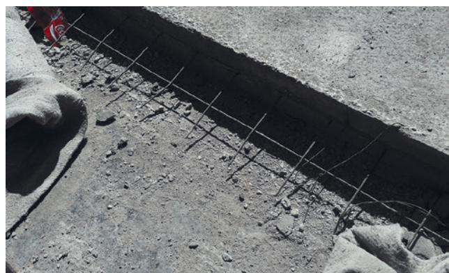
Рис. 4.11. Защитная стяжка
