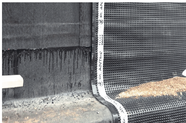
Рис. 4.20. Защита гидроизоляционной мембраны профилированной мембраной PLANTER standard и экструзионным пенополистиролом XPS ТЕХНОНИКОЛЬ CARBON PROF
