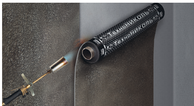
Рис. 5.6. Сварка нахлестов с последующей механической фиксацией рулона
