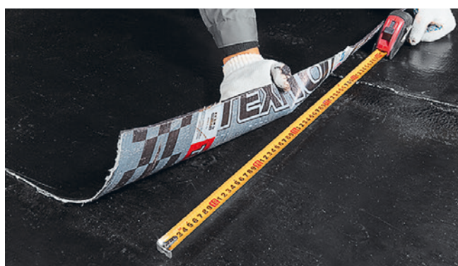
Рис. 4.13. Выставление нахлеста между рулонами первого и второго слоев
