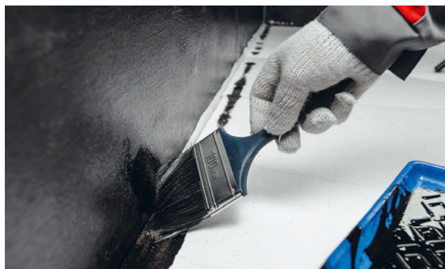
Рис. 3.7. Нанесение праймера кистью в зоне угла
