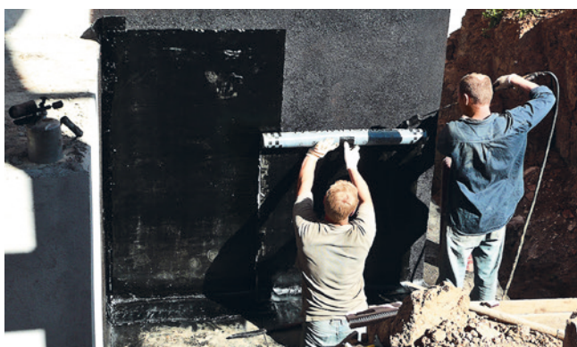
Рис. 4.17. Ручная и механическая подача рулона
