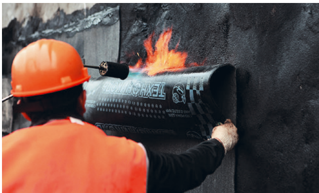
Рис. 2.3. Метод сплошного наплавления
