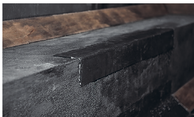
Рис. 4.3. Слои усиления на внешнем угле при смене плоскости наплавления
