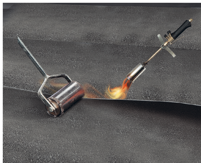
Рис. 5.1. Сварка рулонов в зоне нахлеста при свободной укладке материала
