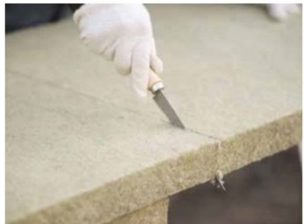
2. Резка плит ТЕХНО ОЗМ
