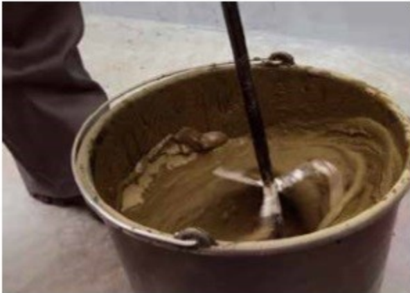
3. Затворение клеящей смеси
