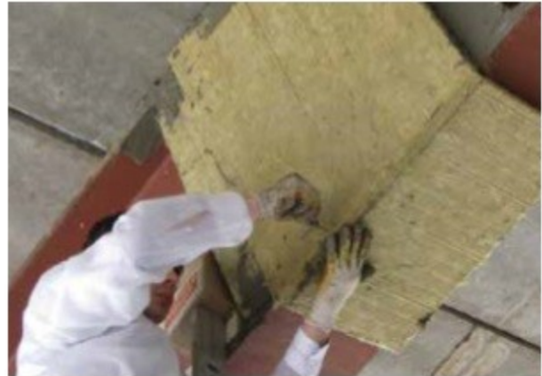
5. Монтаж огнезащитных плит ТЕХНО ОЗМ
